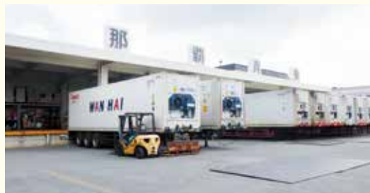
冷蔵冷凍施設は築44年が経過しており、業容の拡大により現在は5棟ある
