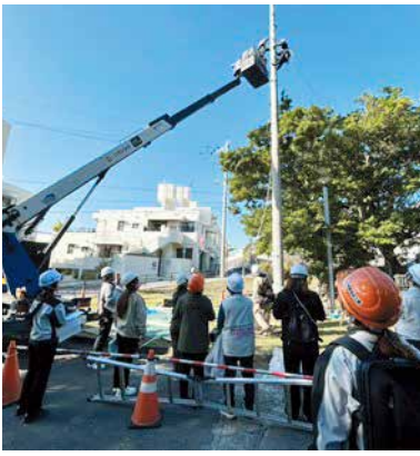
現場視察で作業工程を学んだ
